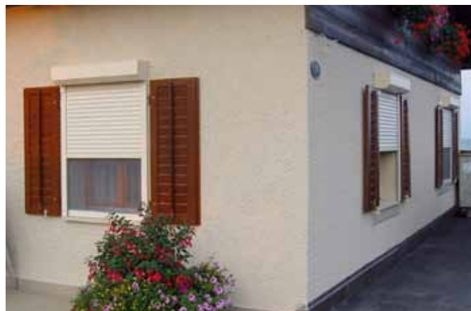
MONTFIX, rénovation d'une maison individuelle
