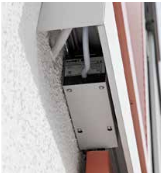
Moteur en situe, installation invisible | Azionamento a scomparsa
